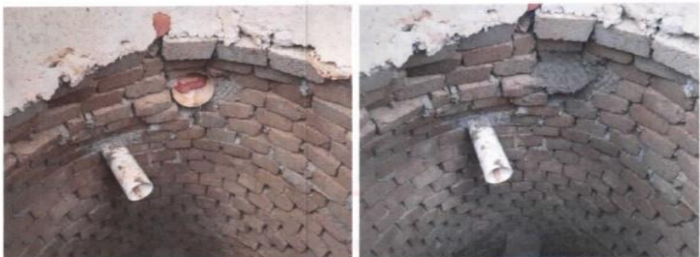
Cancelación de la conexión de la fosa séptica al pozo de absorción, queda únicamente el tubo colector de agua pluvial.
