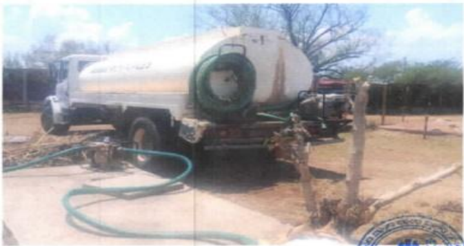
Vaciado periódico de la fosa de aguas residuales del barajillo
