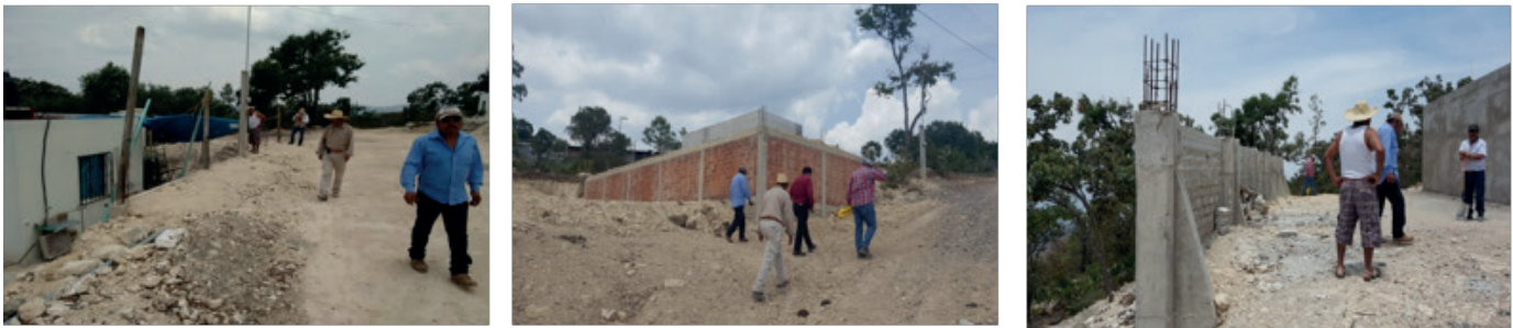
Obras de urbanización segunda etapa en Santa Cruz Mitlatongo Agencia de Magdalena Jaltepec.
