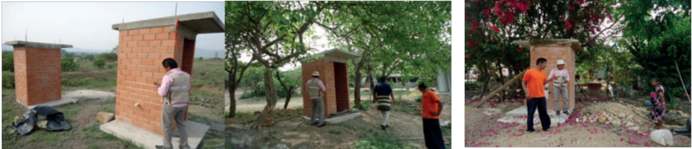
Construcción de sanitarios con biodigestores para el mejoramiento de vivienda. Coatecas Altas.
