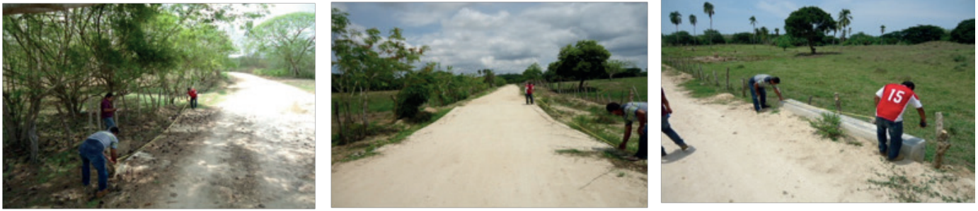
Reconstrucción del camino Santo Domingo Armenta - Santiago Tapextla del km 0+000 al 7+000.
